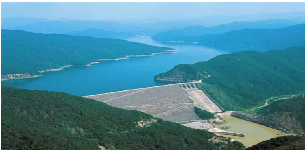
[그림 1] 소양강 다목적댐 전경
