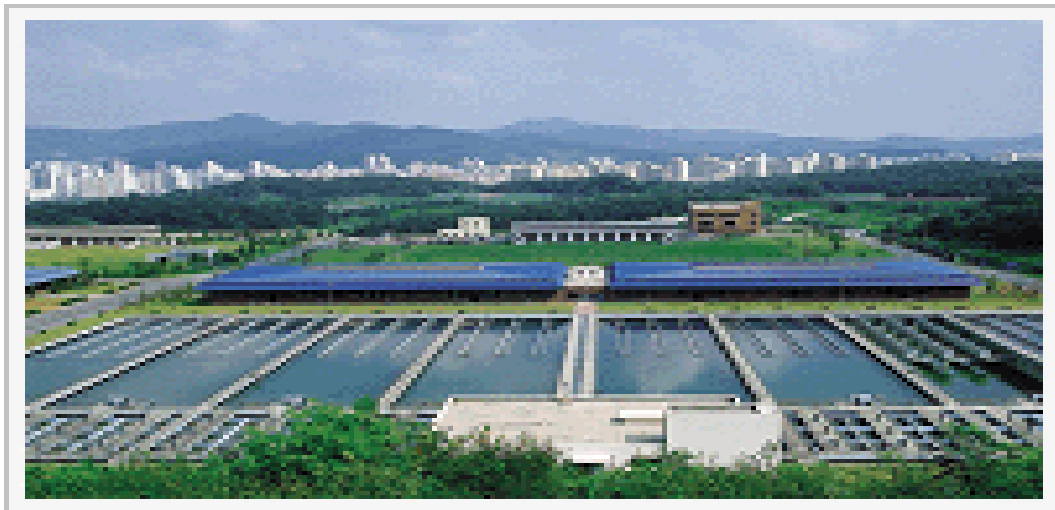
[그림 2] 수도권 3, 4단계 광역상수도 시설 (성남정수장) 전경
